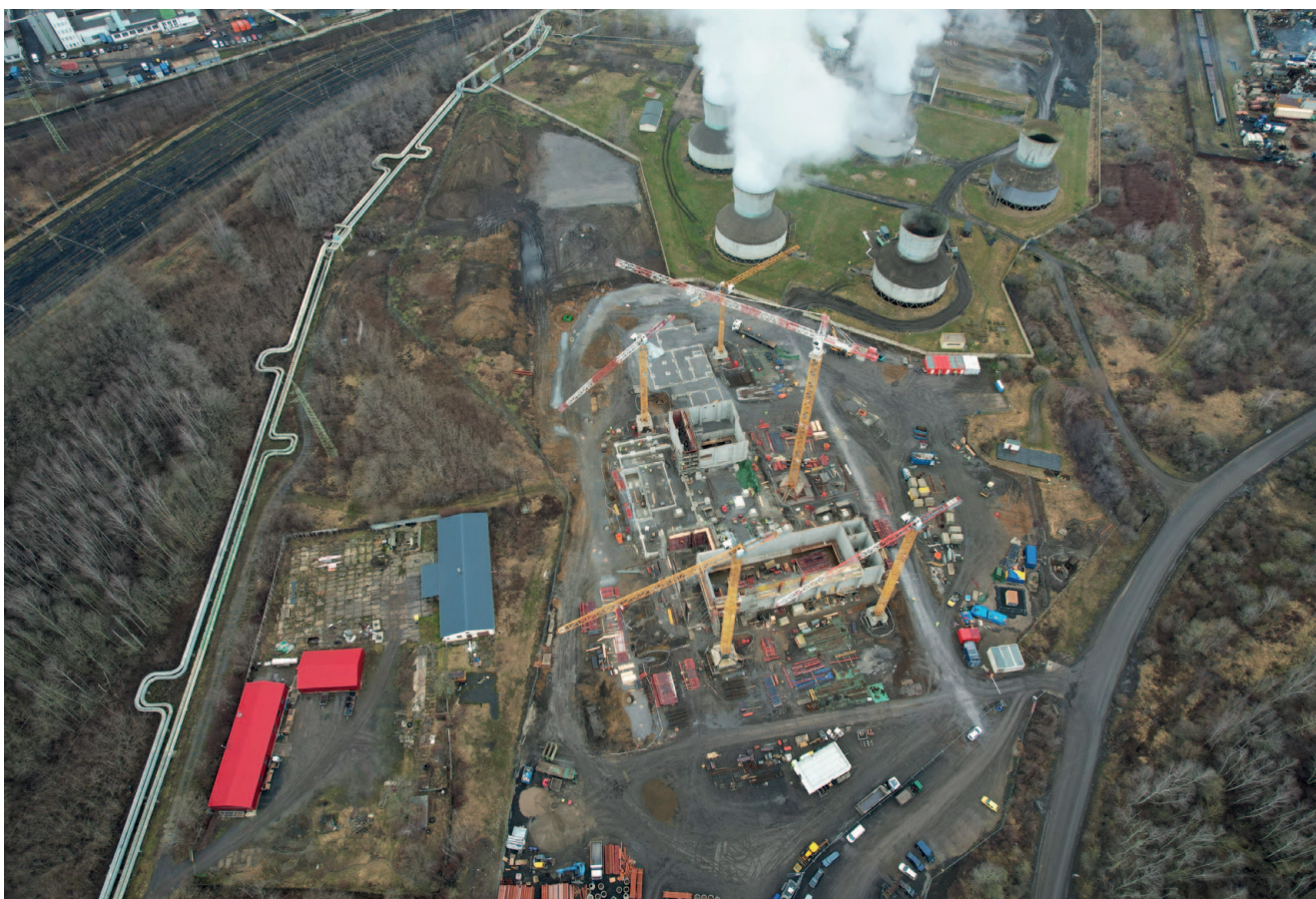
Pohled z dronu na staveniště v komořanské lokalitě
