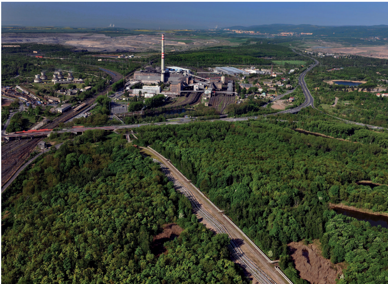
Teplárnu v Komořanech zahajuje náročnou přestavbu, na jejímž konci bude plně funkční nízkoemisní energetická lokalita
