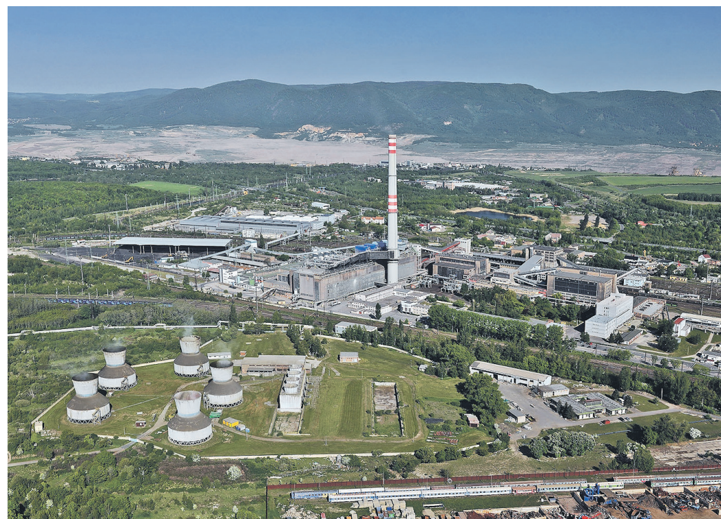
Nové ZEVO se buduje ve stávajícím průmyslovém areálu teplárny Komořany.
